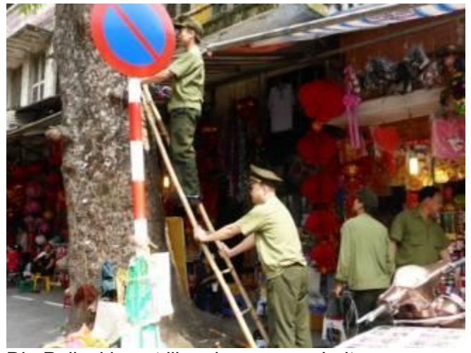
Die Polizei kappt illegal gezogene Leitungen
