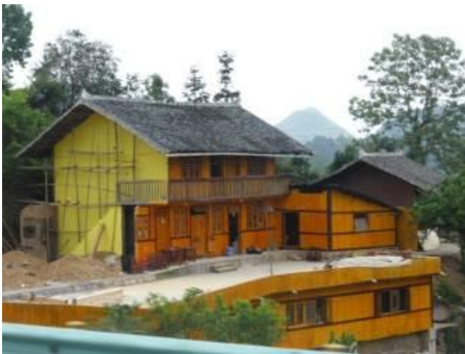
Die moderne Bauweise aus Beton und Ziegel imitiert die traditionelle Bauweise: Die Holz- und Bambuswände werden aufgemalt
