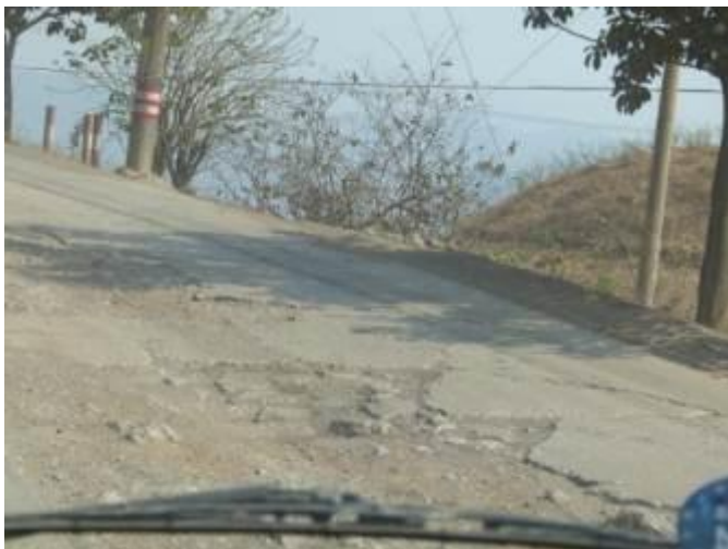
Die Straßen werden immer schlechter
