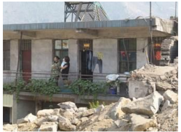
Häuser werden für eine neue Straße abgerissen, ohne dass die Bewohner schon umgesiedelt sind
