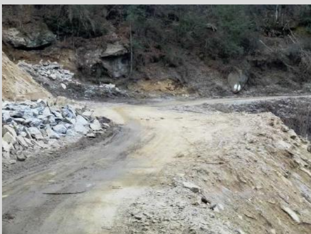
Feucht wird der Untergrund auch noch
