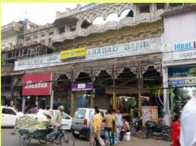
Zerfall überall, wie hier bei dieser Bank
